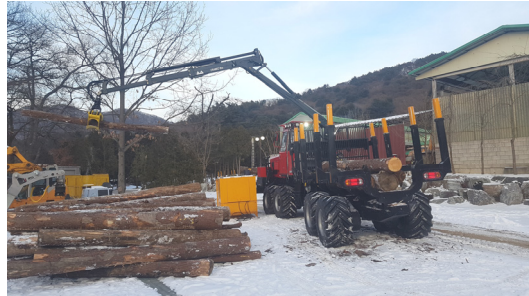
(b) 헤드보드 및 적재물 상승 시 작업
